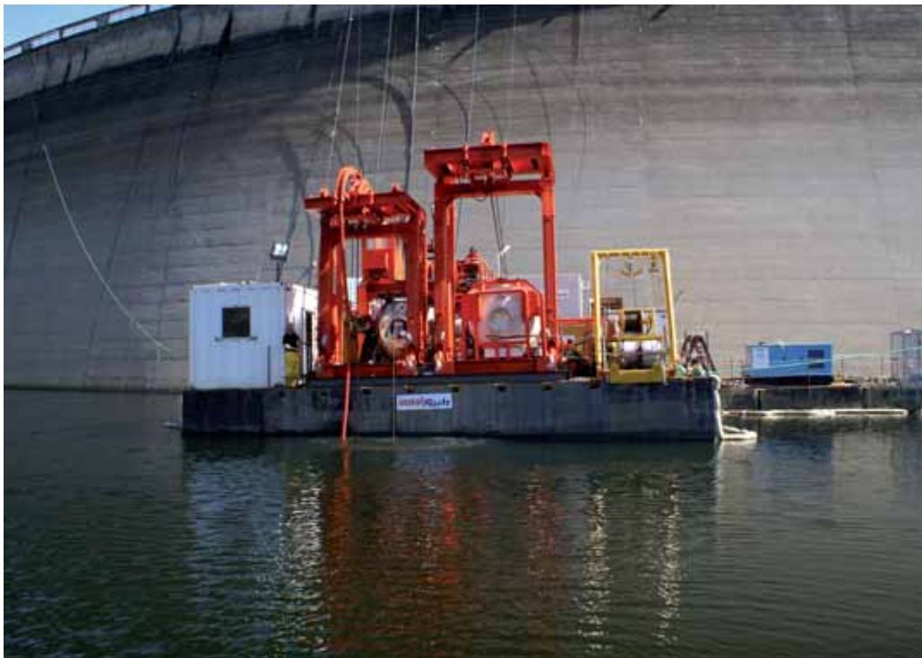
Instalsub ha hecho su primer trabajo de saturación en el pantano del Salto del Belesar, en Lugo.
